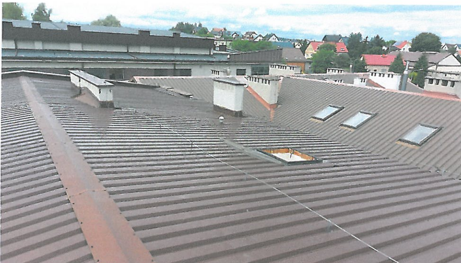
Fot. Nr 1 – Widok ogólny dachu – obróbki blacharskie kalenicy, kominów, murów attyk
