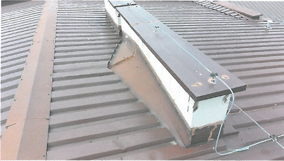
Fot. Nr 4 – Widok odboju przy kominie i obróbkę blacharskich
