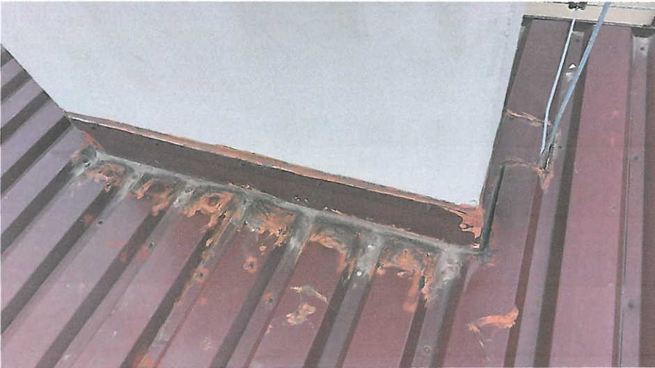
Fot. Nr 5 – Widok odboju przy kominie i obróbkę blacharskich
