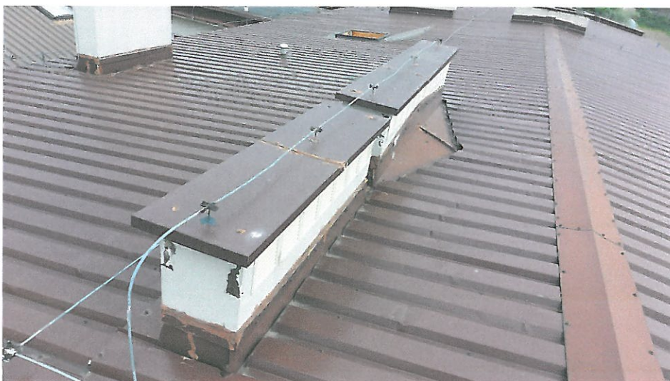
Fot. Nr 2 – Widok ogólny dachu – pokrycie dachu i obróbki blacharskie
