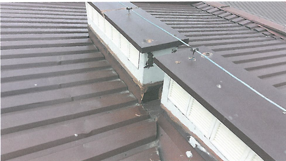
Fot. Nr 6 – Widok odboju przy kominie i obróbkę blacharskich
